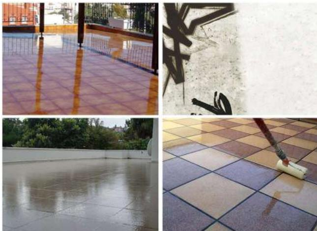
Impermeabilizante bicomponente a base de resina de poliuretano que quando curada apresenta característica de película flexível, alto brilho, resistência a intempéries e durabilidade,
