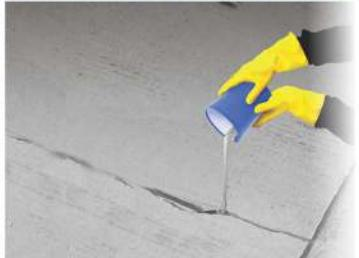
Adesivo epóxi estrutural
