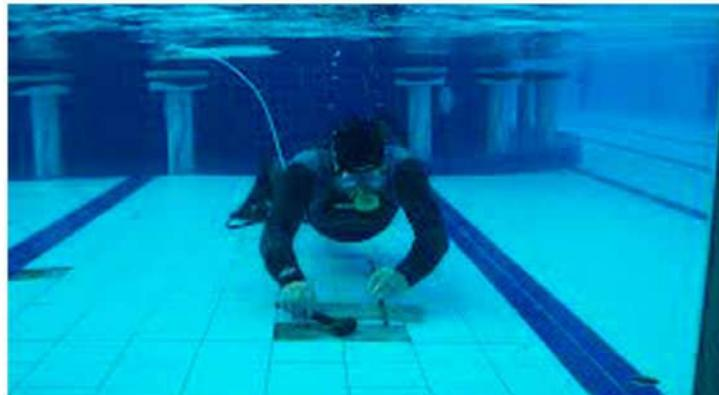
Sistema bicomponente a base de resina epóxi e endurecedor poliamínico para aplicação subaquática.
